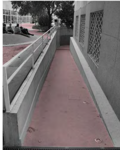
Rampa de conexión con acceso nivel X
