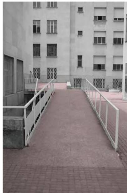
Rampa de acceso terraza
